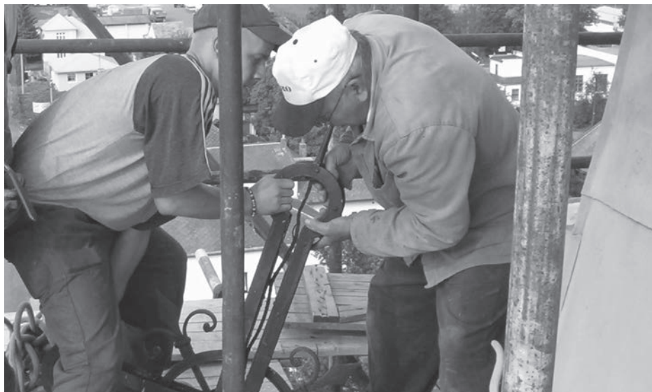
KOSTEL MÁ ZA SEBOU 1. fázi oprav, jejíž součástí byla také oprava střechy. Fotografie je z 29. srpna, kdy byl z věže odstraněn kříž a stará kopule. Foto Michal Novotný
