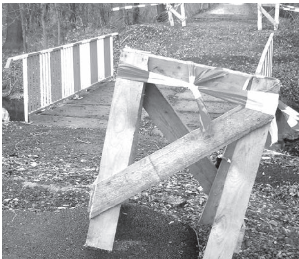
MOST U ČERNÉHO MLÝNA, přes který nedávno vedla objízdná trasa, čeká na jaře rekonstrukce.
