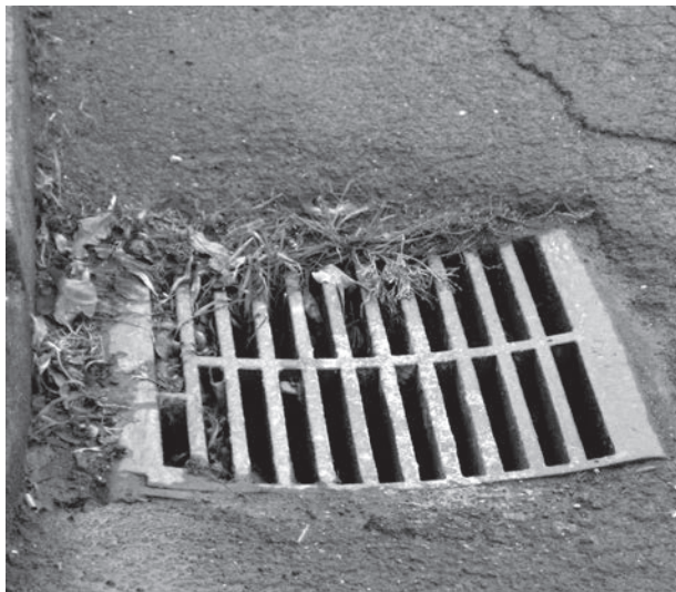
VÝSTAVBA KANALIZACE je pro příští roky jednou z priorit Komárova. Ilustrační foto Michal Novotný
